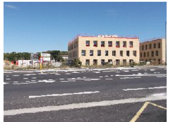
Le nouvel arrêt de bus «Maison d'arrêt»
